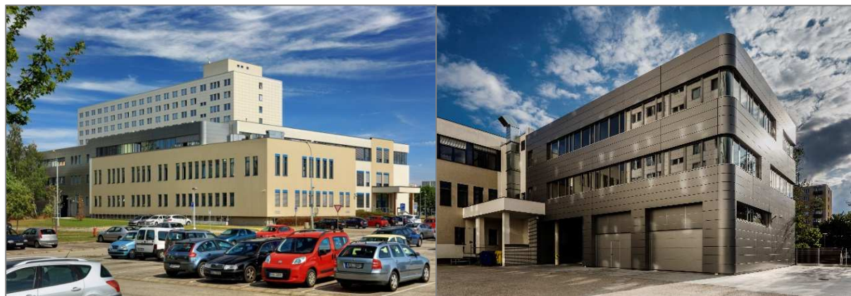
Obr. 9.3.4 Objekt Vltava Zdravotně sociální fakulty JU v Boreckého ulici. Západní pohled (vlevo), pohled ze dvora (vpravo). Foto: Libor Sváček.
